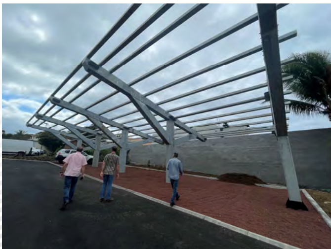
Figure 2 : Construction de la structure
